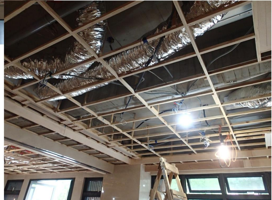
1樓大廳天花板上冷氣風管施作
