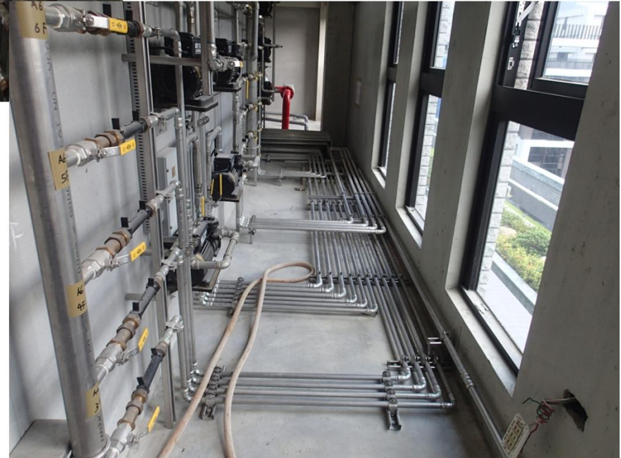
R2F水錶室內步道施作(施作前)
