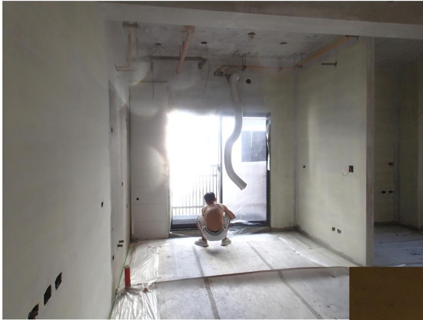
各戶室內油漆噴漆前施作保護(鋁窗,吊管包覆)
