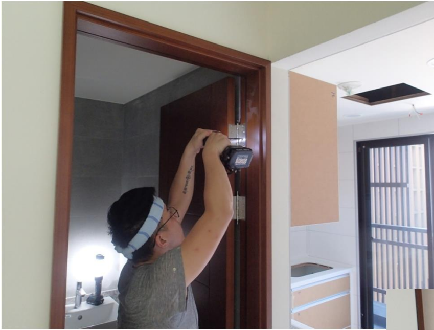
木門扇安裝固定
