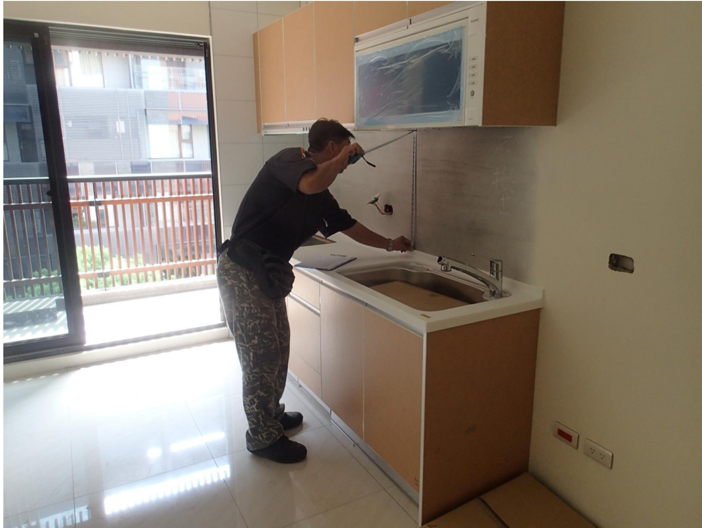
各戶室內廚具及檯面安裝完成後,烤漆玻璃丈量
