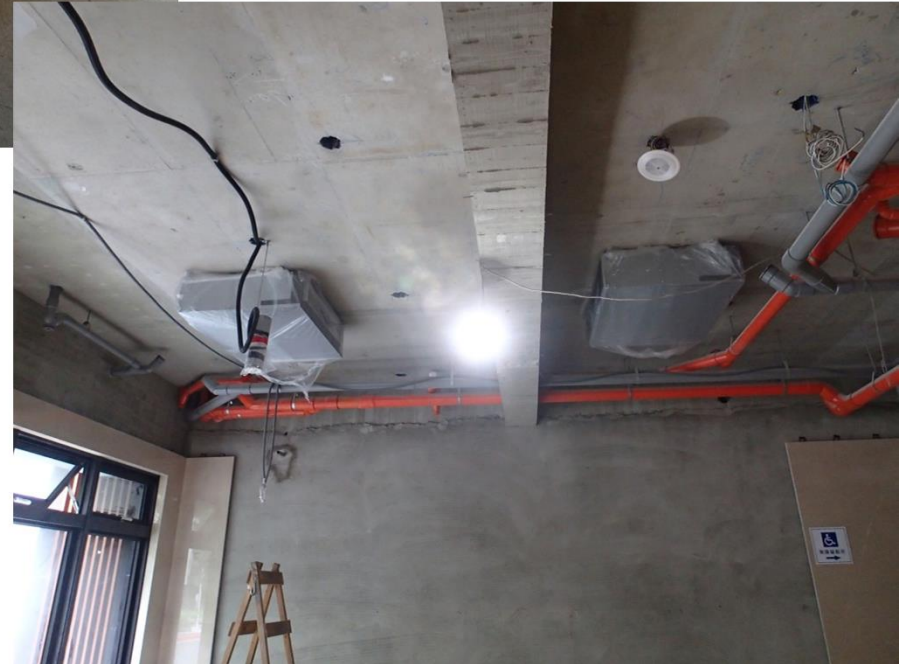
1樓大廳吊隱機安裝
