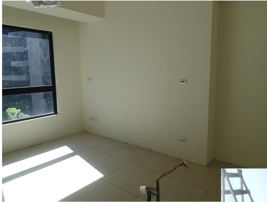
噴底漆完成後照片
