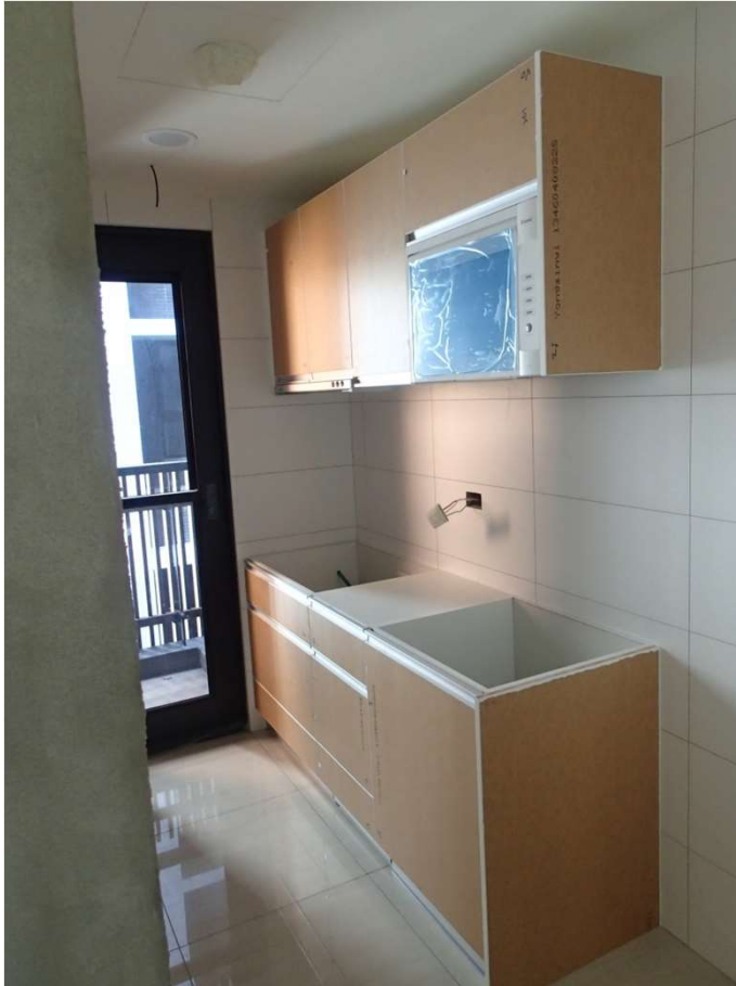
各戶室內廚具安裝完成照 (標準戶A2戶)
