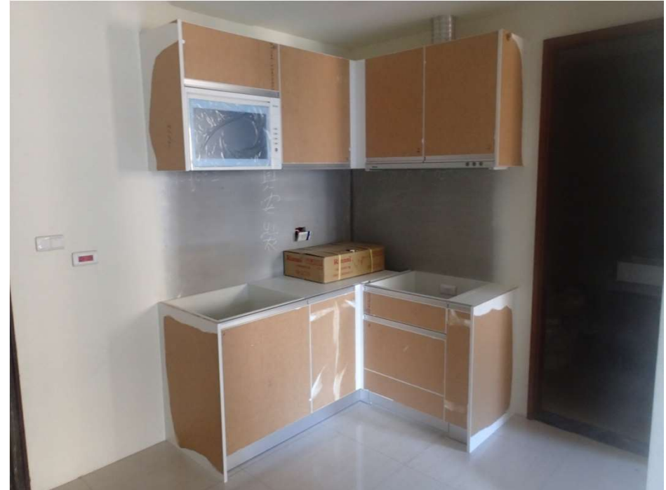
各戶室內廚具安裝完成照 (標準戶B3戶)
