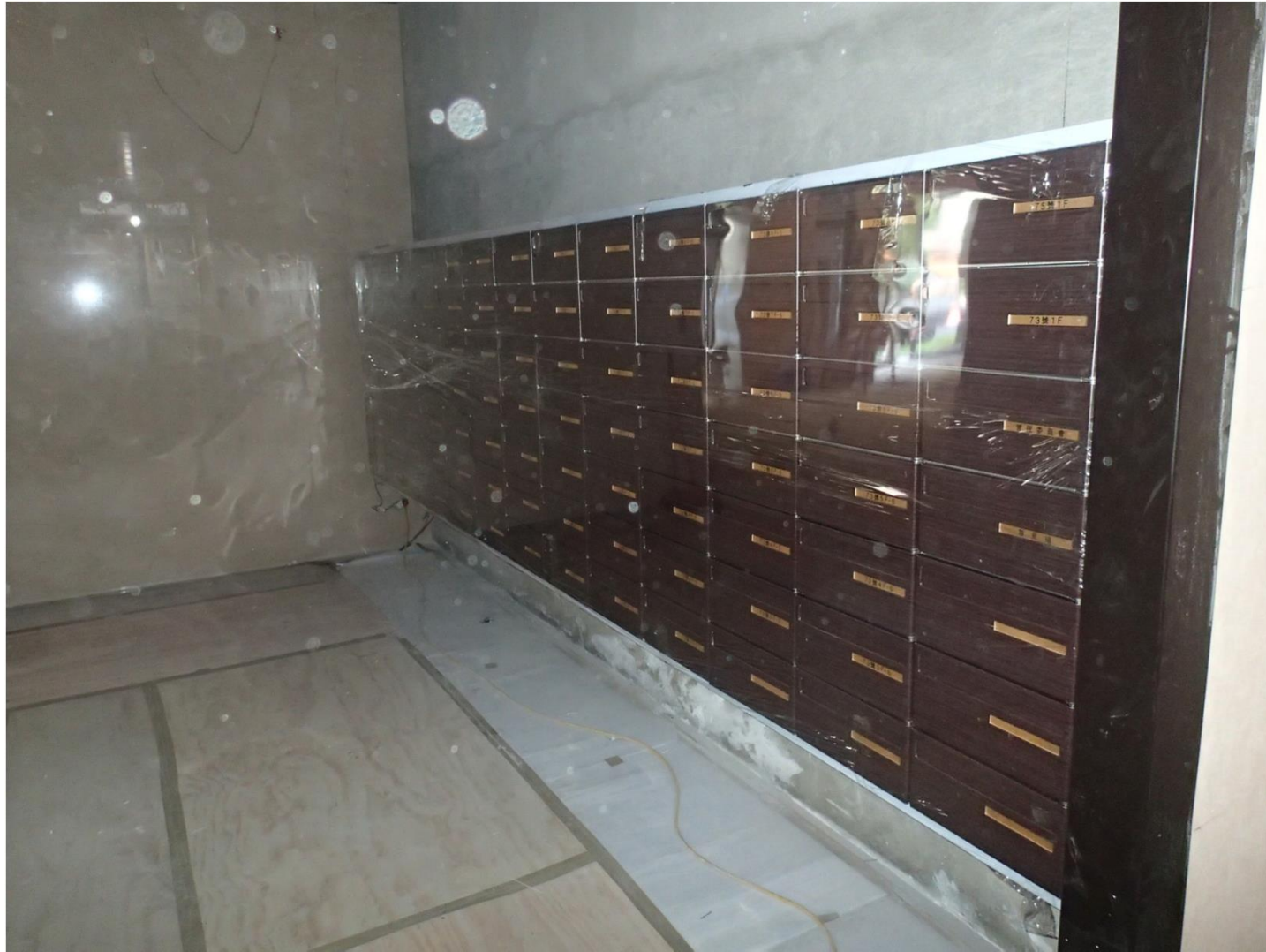
1樓信箱安裝完成照
