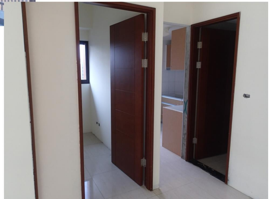
木門扇安裝完成照
