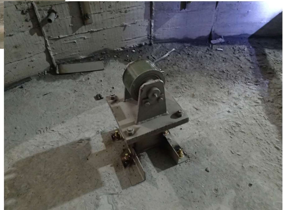
B1F汽車旋轉盤下輔助輪安裝固定
