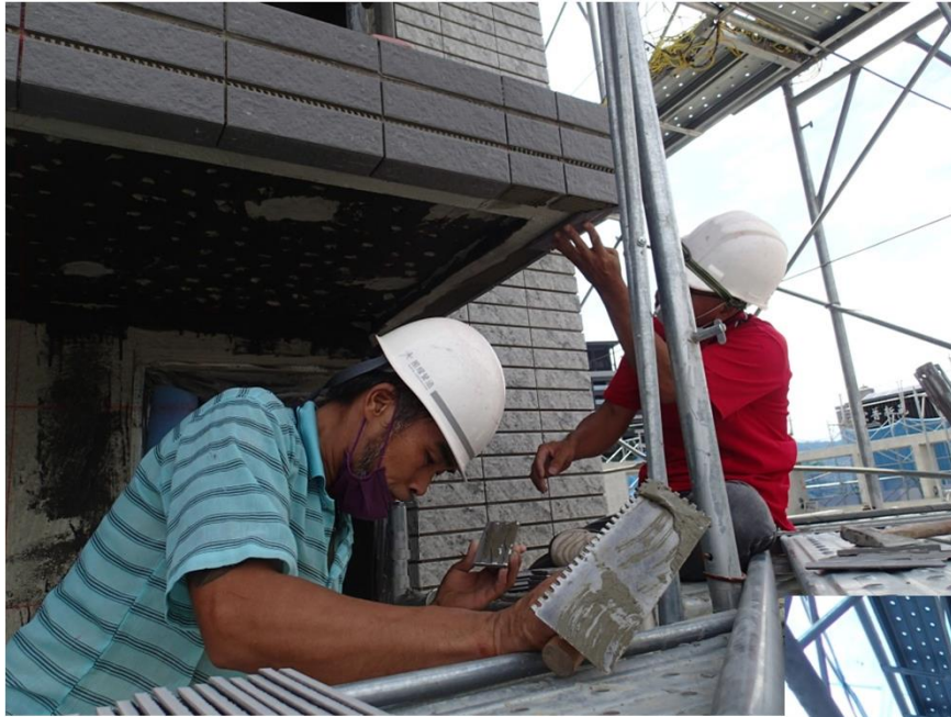
正面R1F雨遮磁磚貼磚施作
