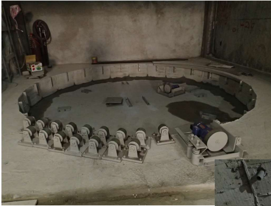
B1F汽車旋轉盤下輔助輪安裝固定
