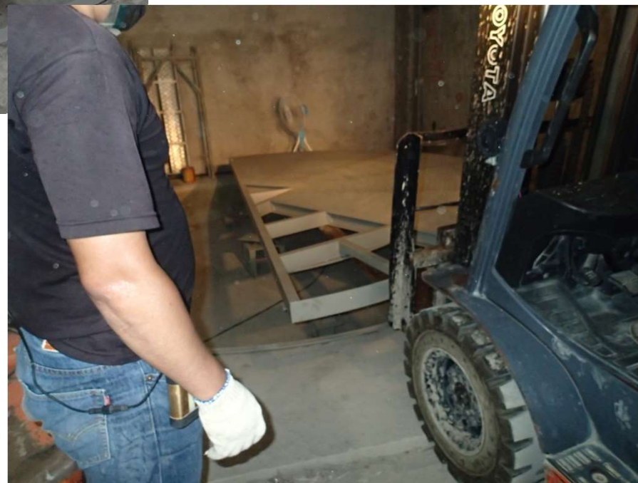
B1F汽車旋轉盤安裝
