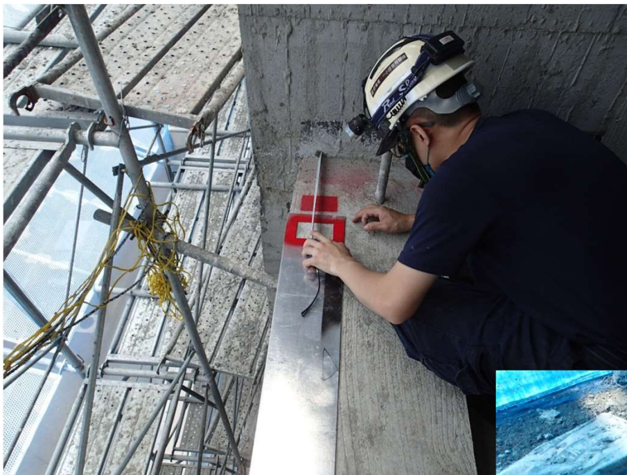
陽台欄杆墩座欄杆立柱位置放樣
