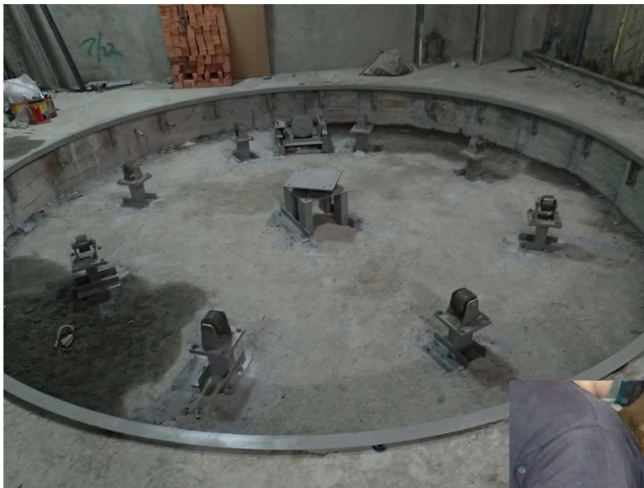
B1F汽車旋轉盤下輔助輪安裝固定完成
