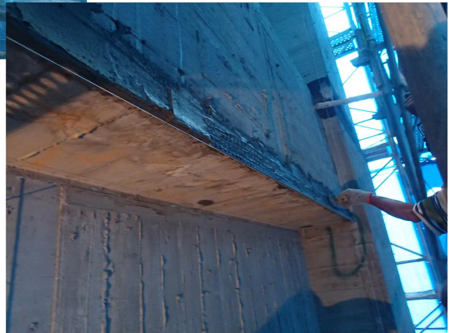
後側外牆樑泥作吊線後誌誌 施作
