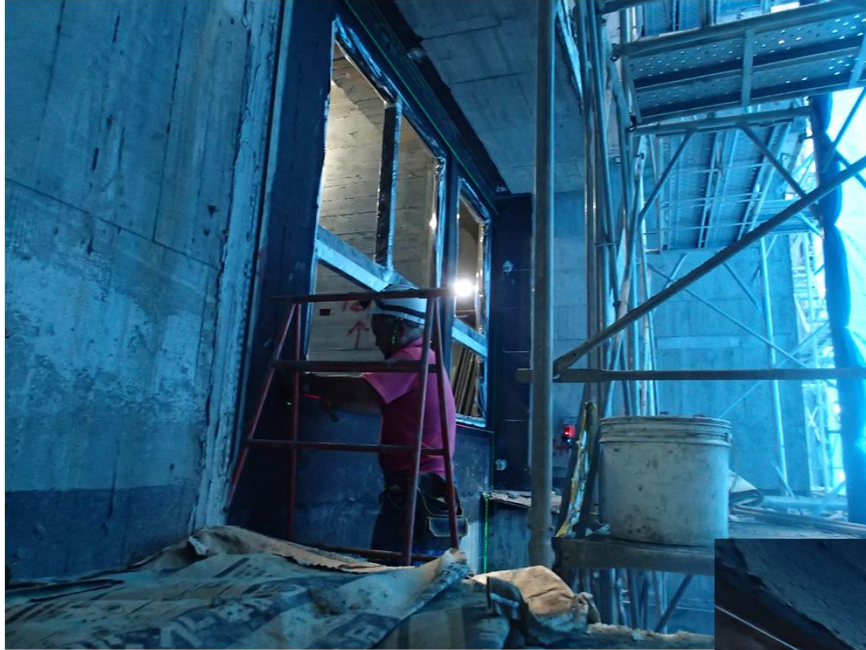
後側外牆窗邊泥作吊線
