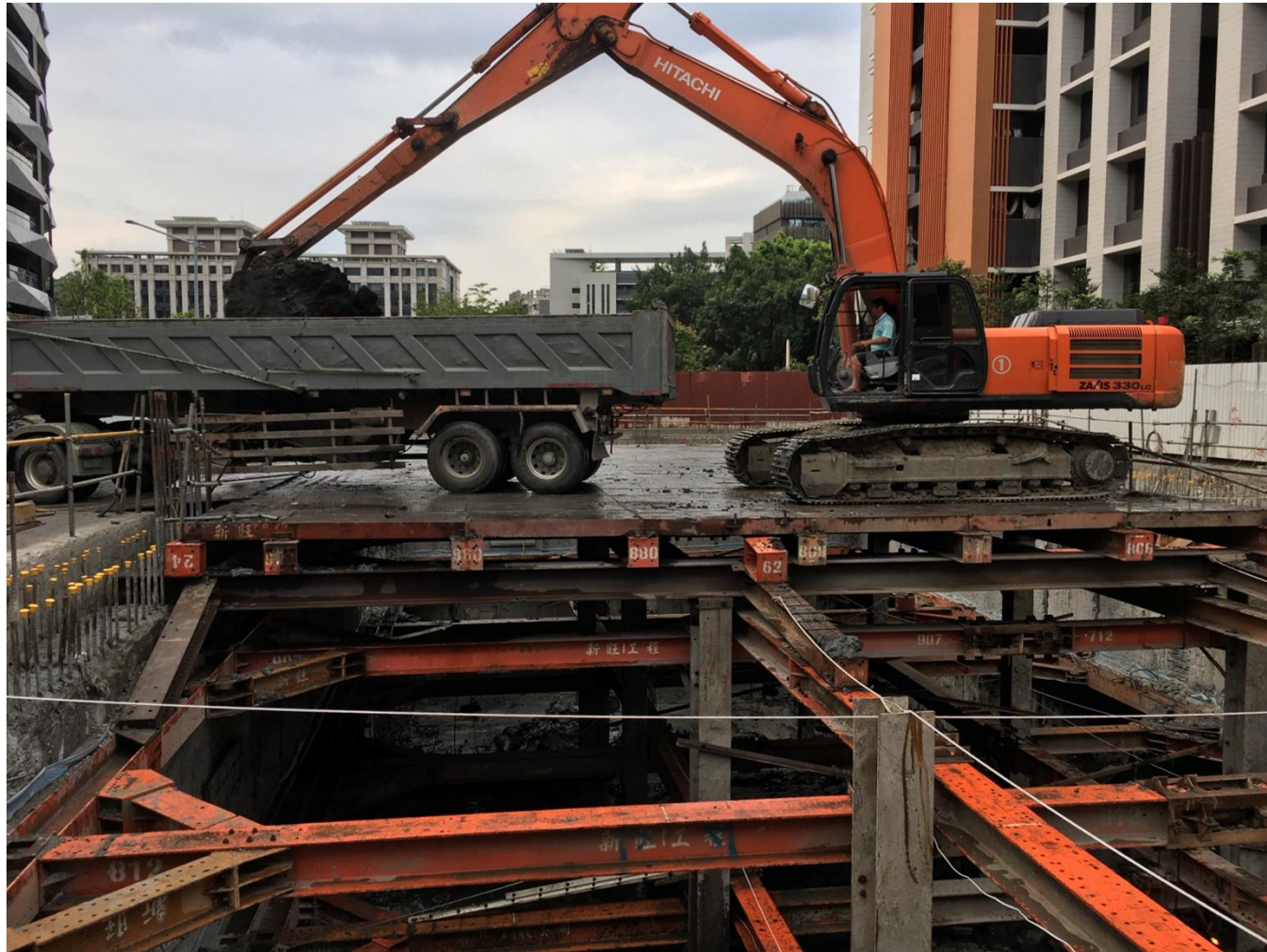
第三層土方開挖施作
