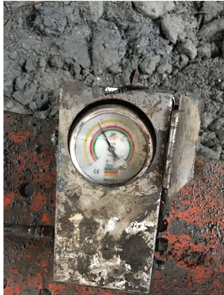
油壓機及土壓計(安裝完,油壓機加壓千斤頂,土 壓計顯示 千斤頂壓力)(第三層支撐壓力100T/支)
