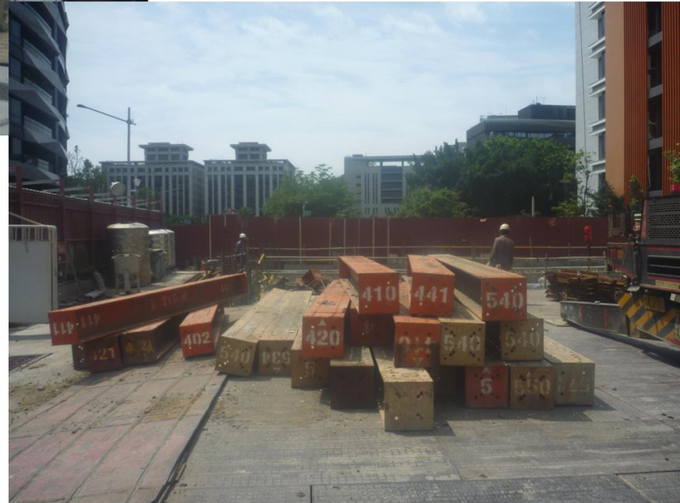
安全支撐型鋼進場,(上方數字為 型鋼長度)
