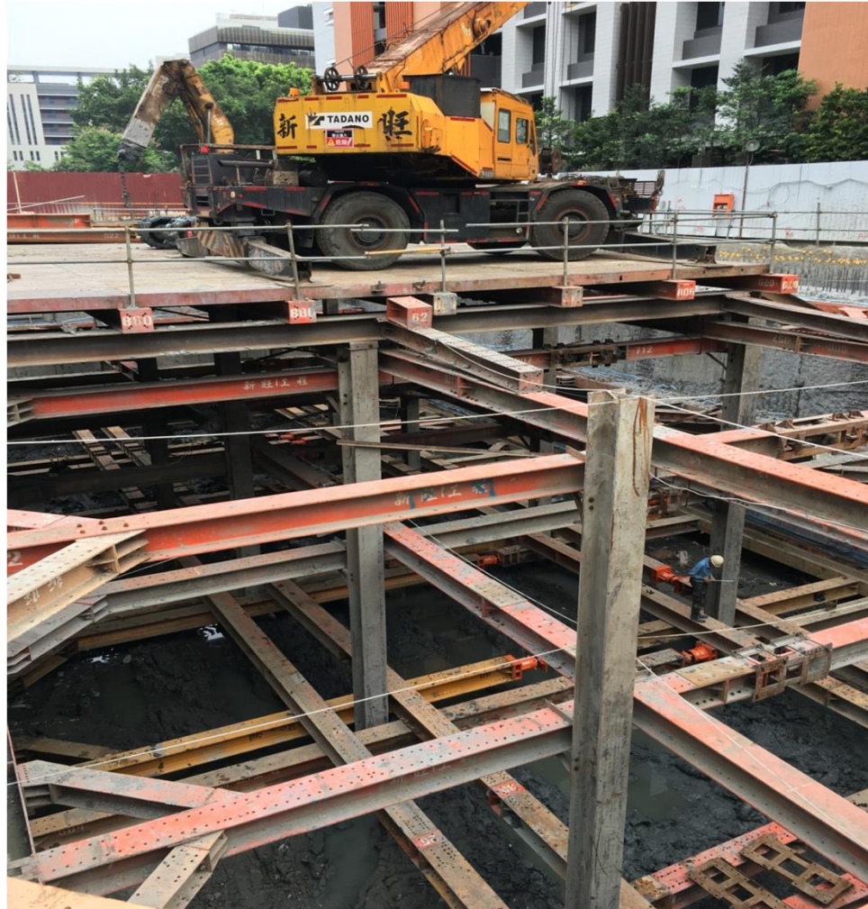
第三層安全支撐組裝完成
