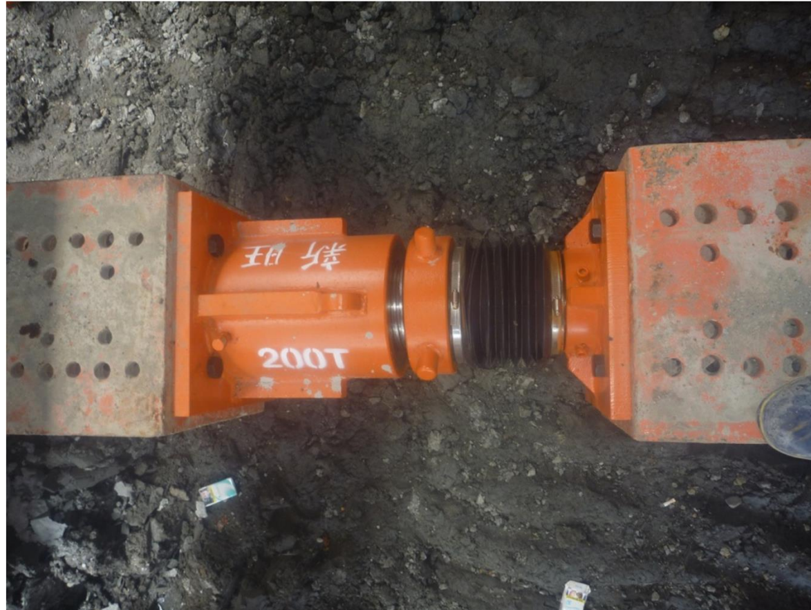
油壓千斤頂安裝
