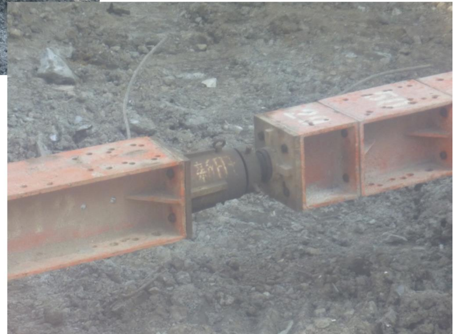
安裝油壓千斤頂
