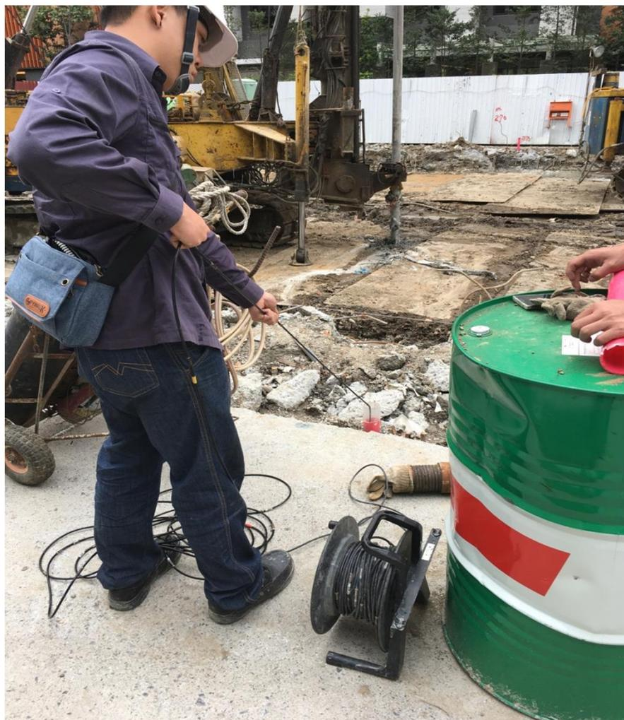
施作地質改良時,連續壁壁體安全觀測
