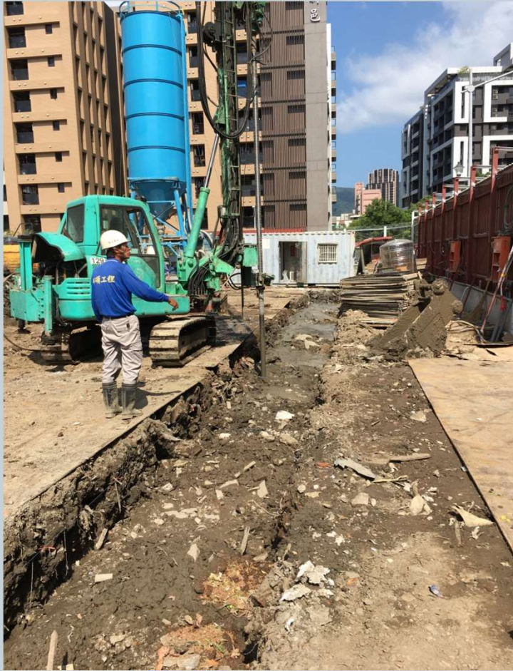
連續壁導溝 施作處地質改良
