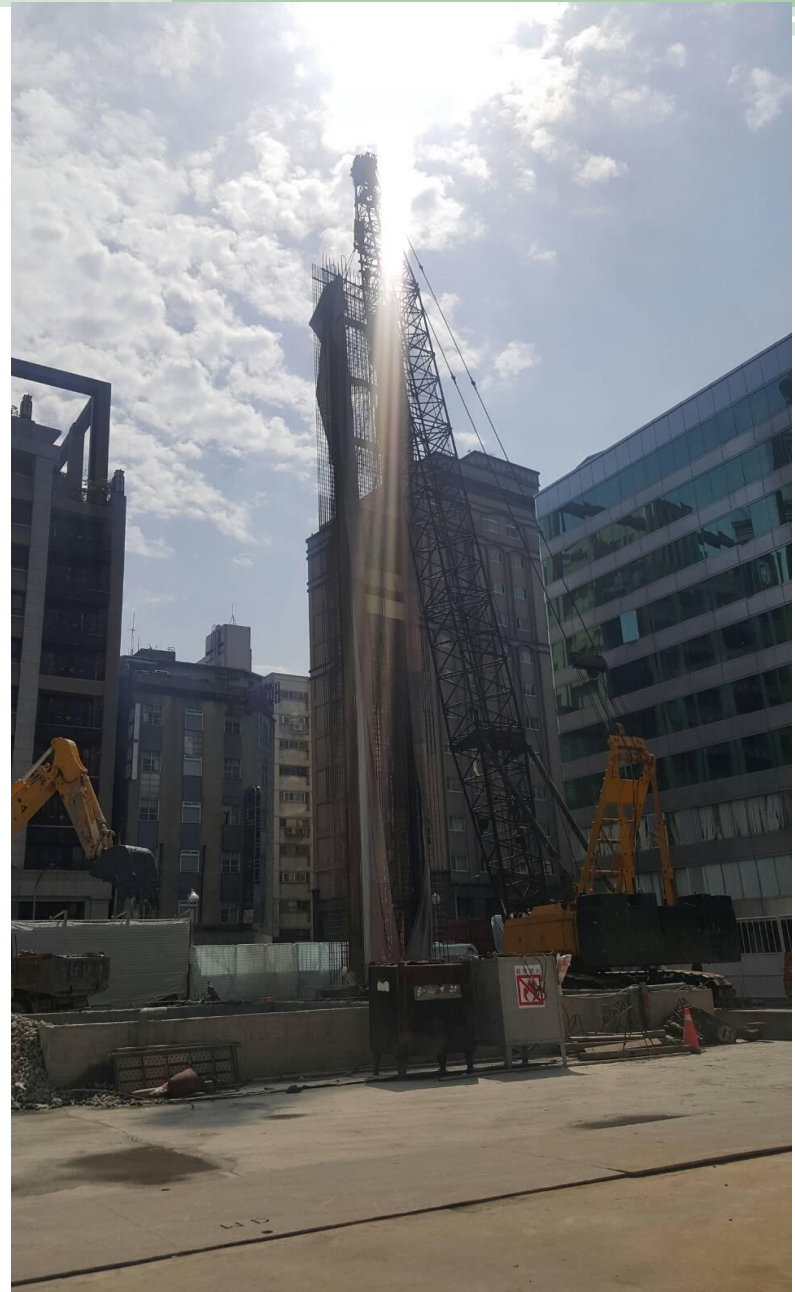
36 M 鋼筋籠吊放
