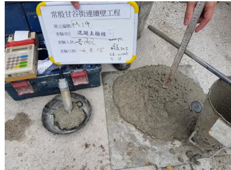
混凝土坍度, 氯離子檢測
